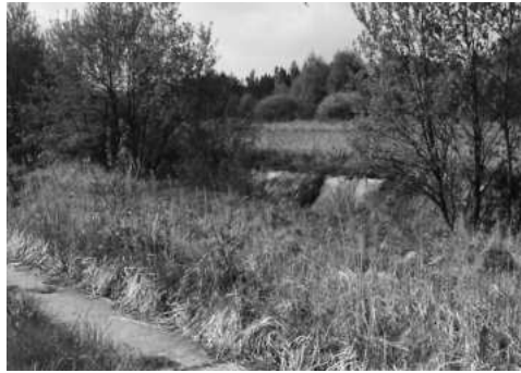
Abb. 88: Ausschnitt des NSG „Himmelreich“ mit Kolonnenweg, ehemaligem Kontrollstreifen, Sperrgraben, vorgelagertem Hoheitsgebiet und Grenze zu Bayern (Wald im Hintergrund) Foto: R. Weber
