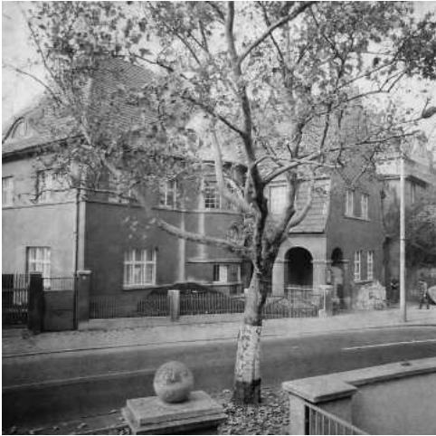
Abb. 38: Das Gebäude des ILN in Halle. Foto: ILN
