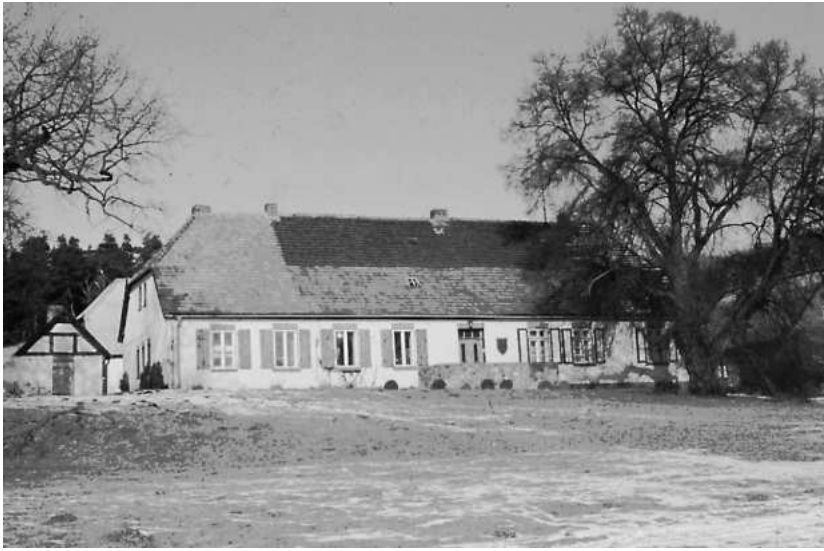
Abb. 50: 1954 wurde in Müritzhof die erste Lehrstätte für Naturschutz gegründet. Die Aufnahme zeigt die Zentrale Naturschutzlehrstätte der DDR im Winter 1980.
